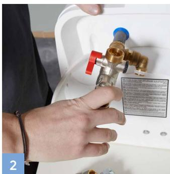
2 Monter les raccords hydrauliques
