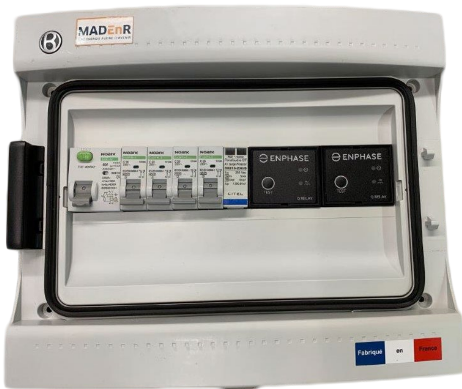
Figure 28 : Photo et vue du dessous coffret AC MONO 2 arrivées micro-onduleur 3-6kW ref 21100621
