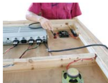
FIG-19 Paso los cables al interior de la sauna
