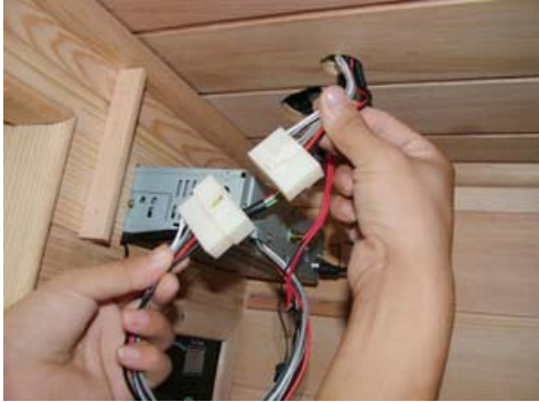
FIG-20 Conecte los cables del CD
