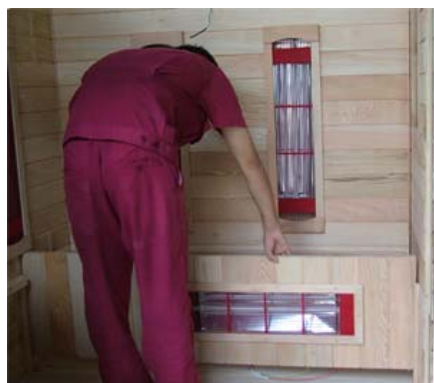
FIG-9 Instalación panel inferior largo calefactado
