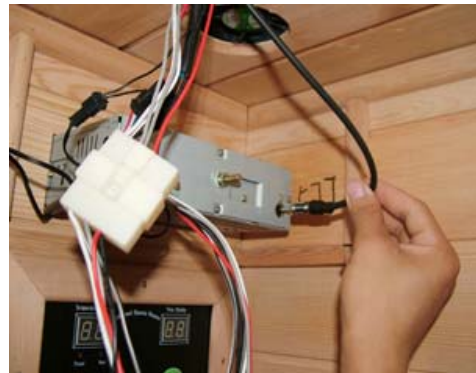
FIG-23 Conecte el cable de la antena
