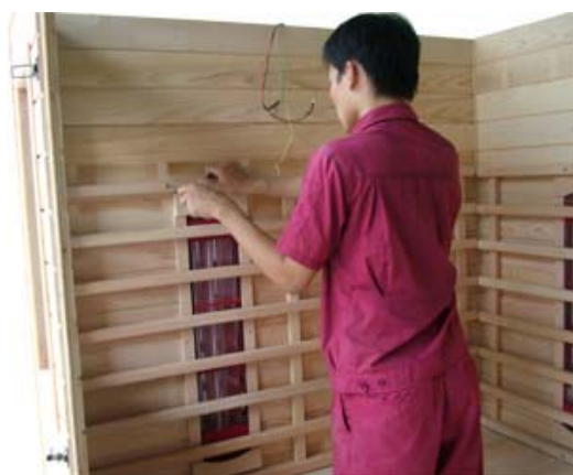
FIG-13.1 Afixe o descanso de costas com parafusos
