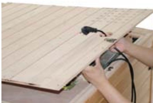
FIG-25 Saque el enchufe por el agujero correspondiente del panel del techo exterior
