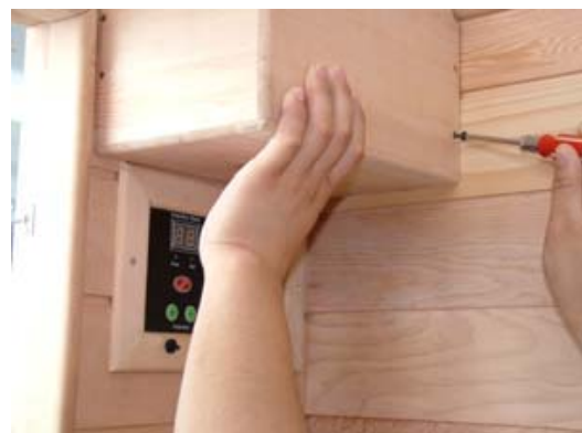
FIG-24.1 Fije la caja con tornillos
