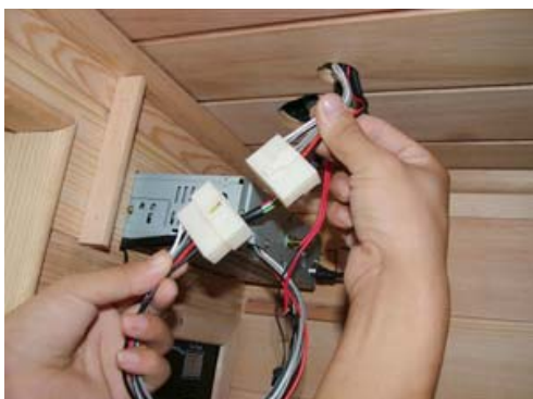
FIG-20 Ligue os fios do leitor de CDs
