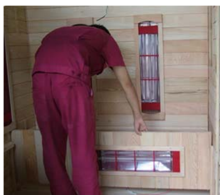
FIG-9 Monte o painel grande de sustentação do assento
