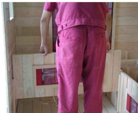
FIG-10 Instalación panel inferior corto calefactado
