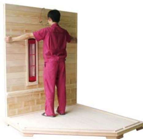
FIG-4 Instale el panel izquierdo posterior
