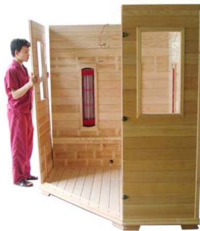
FIG-8 Instalación del panel lateral izquierdo
