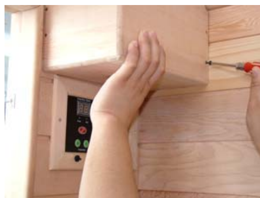
FIG-24.1 Afixe o leitor de CDs na parte de trás com parafusos
