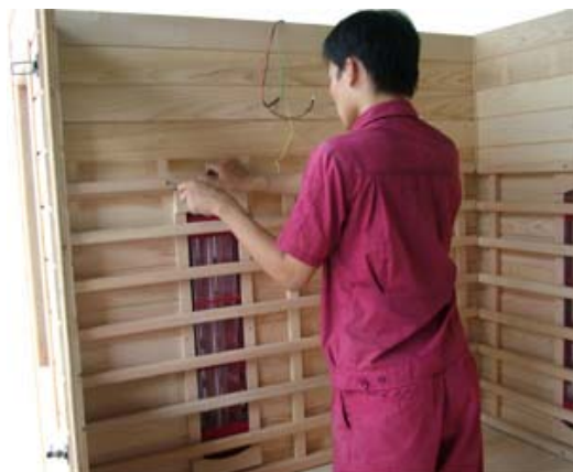
FIG-13.1 Fije los respaldos con tornillos
