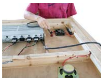
FIG-19 Coloque os fios na cabine da sauna
