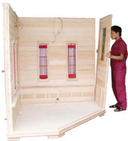
FIG-7 Instalación del panel lateral derecho
