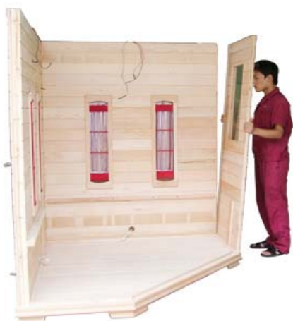
FIG-7 Coloque o painel do lado direito
