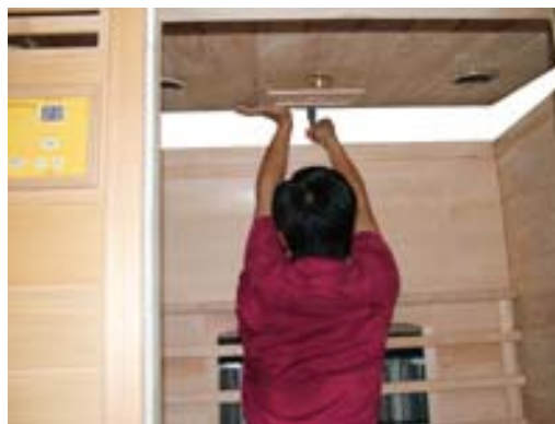
FIG-17 Conduza aos fios do calefactor ao painel através do furo correspondente
