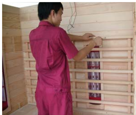
FIG-13 Fije los respaldos con tornillos
