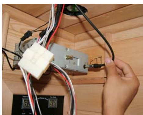
FIG-23 Ligue os fios da antena
