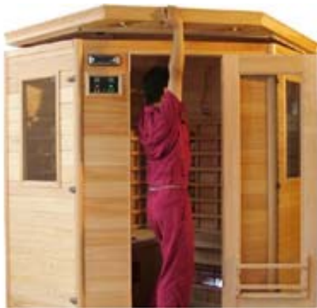
FIG-16 Instalación del panel del techo interior
