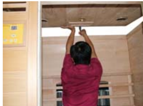
FIG-15 Conduza aos fios dos calefactores no painel através do furo correspondente
