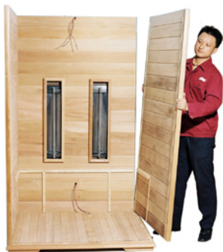
FIG-7 Instalación panel derecho
