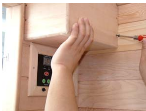
FIG-22.1 Afixe o leitor de CDs na parte de trás com parafusos
