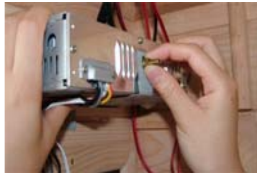
FIG-13.3 Fije el CD con los soportes metálicos
