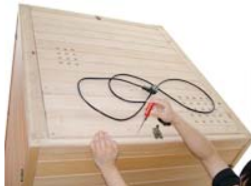
FIG-23 Pase el enchufe a través del agujero del panel superior del techo FIG-24 Fije el panel superior con tornillos
