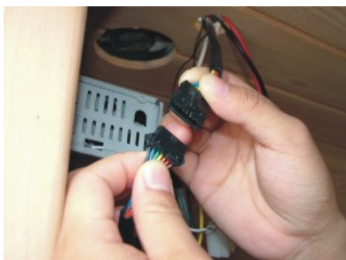
FIG-20 Ligue os fios no painel de controle
