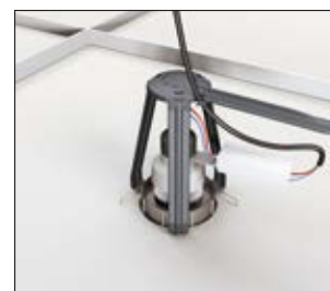
4. Passez le câble d'alimentation dans la patte de fixation.
