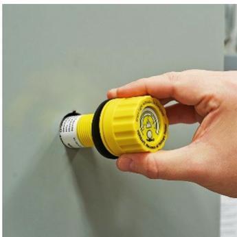
1. Insérer le module indicateur dans le trou de 30 mm de l'ouverture défonçable, tout en alignant l'encoche d'anti-rotation. S'assurer que la rondelle en caoutchouc est placée à l'extérieur du tableau.
