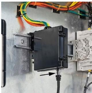
6. Insérer l'autre extrémité du câble système du VAT dans le connecteur à la partie inférieure du module d'isolement.
