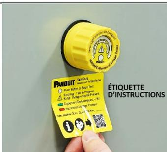
9. Apposer l'étiquette d'instructions à l'extérieur du coffret, directement sous le module indicateur ou à côté de ce dernier (voir Remarque 1). Indiquer sur l'étiquette l'emplacement où le VAT est installé dans le circuit.
