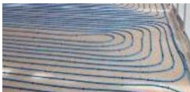
Les dalles planes pour planchers chauffants conviennent pour les applications planchers chauffants électriques ou hydrauliques. Elles assurent les fonctions d'isolation thermique, de désolidarisation du plancher et de support des éléments chauffants selon les exigences de la Réglementation Thermique, du DTU et CPT en vigueur.
