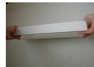
Positionner la partie plâtre sur le support. Attention à ne pas coincer les fils.
