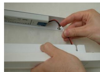
Raccorder le module LED avec le connecteur polarisé.
