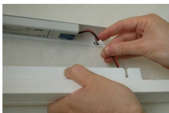
Raccorder le module LED avec le connecteur polarisé.
