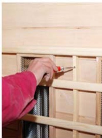
FIG-11 Instalación del respaldo
