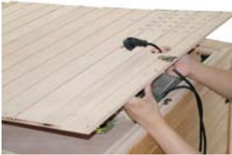
FIG-23 Pase el enchufe a través del agujero del panel superior del techo FIG-24 Fije el panel superior con tornillos
