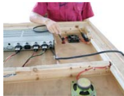
FIG-17 Coloque os fios na cabine da sauna
