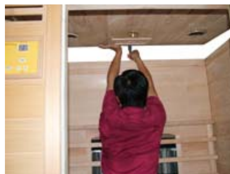
FIG-15 Coloque los cables del calefactor en el panel del techo A través del agujero correspondiente
