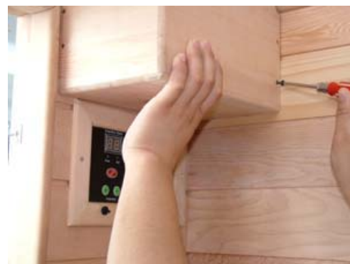
FIG-22.1 Afixe o leitor de CDs na parte de trás com parafusos
