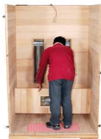
FIG-8 Instalación de la protección inferior del banco
