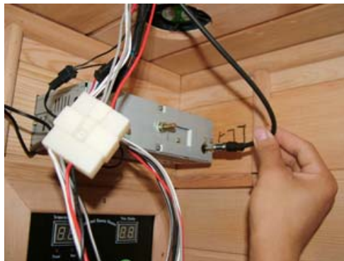
FIG-21 Conecte el cable de la antena
