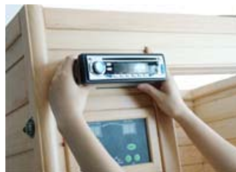
FIG-13.1 Instale el CD
