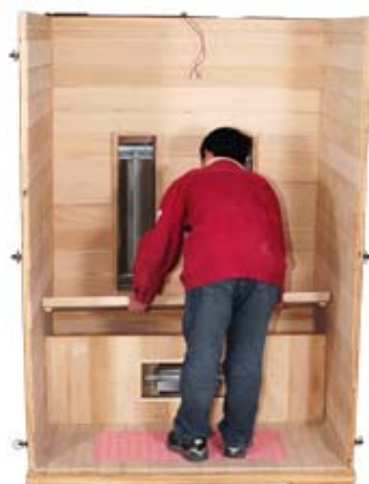
FIG-10 Monte a placa do assento
