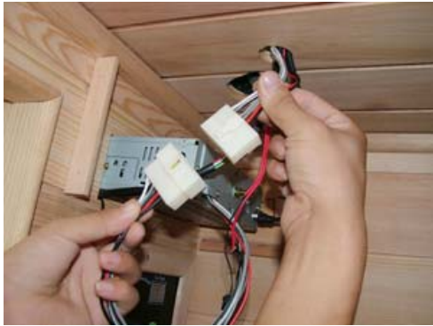
FIG-18 Ligue os fios do leitor de CDs
