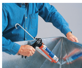
Pose de joint d'étanchéité à l'intérieur d'une coque métallique
