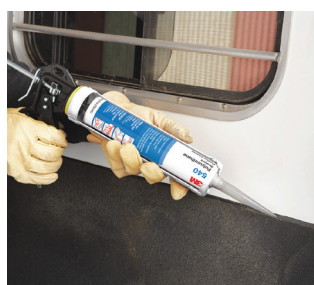
Pose de joint au-dessus d'un siège de train
