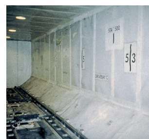
Jointage de panneaux d'isolation avec du ruban tissu de verre
