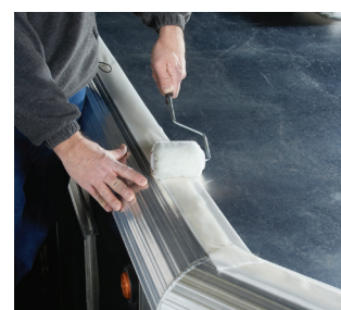
Protection des vis sur une structure aluminium
