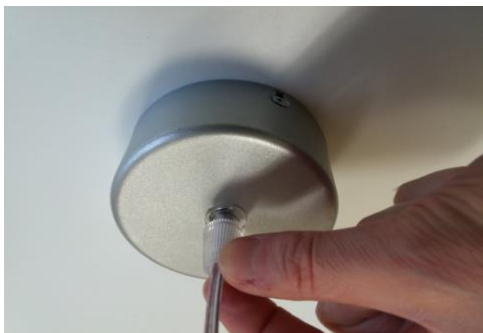
Régler la hauteur et visser le serre-câble.
