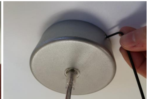
Remettre la patère et fixer à l'aide des 2 vis.
