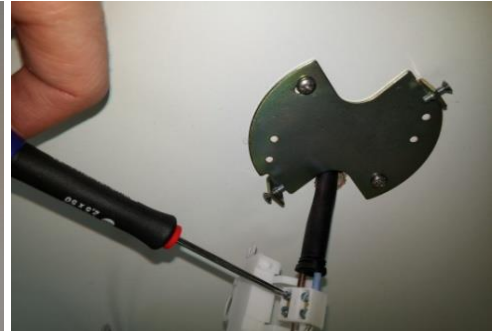
Raccorder au réseau.
