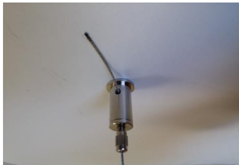
Insérer le câble dans le trou latéral.
