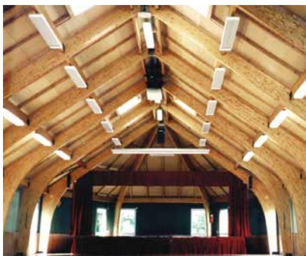
La mise en chauffe de l'EZ200 est très rapide, sans préchauffage, ce qui désigne particulièrement ce mode de chauffage pour locaux occupés sur une base irrégulière.
