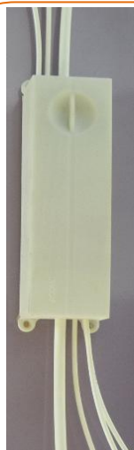
Exemple 1 : Be-box 24 installée dans une gaine technique
