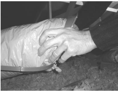
Positionner le fourreau extérieur jusqu'à la rainure A
