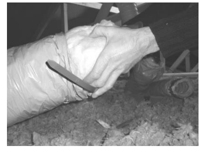
Positionner l'isolant jusqu'à la rainure A
