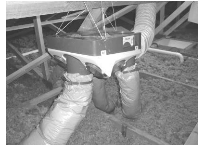
Votre caisson est installé
