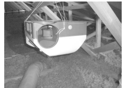
Suspendre le groupe à l'aide la cordelette.
