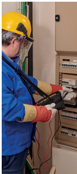
Contrôle d'une armoire électrique
