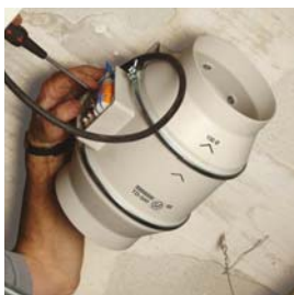
Réaliser les connections.
