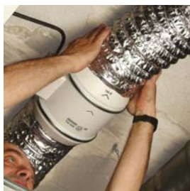
Raccorder les conduits.
