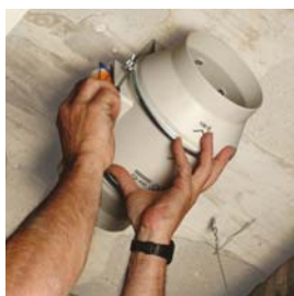
Insérer le corps moteur-hélice.
