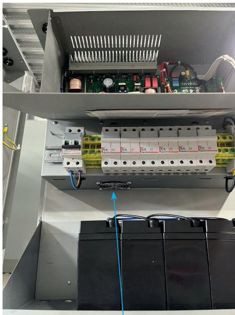
Démontage des 4 vis du ventilateur et de sa grille de protection.
