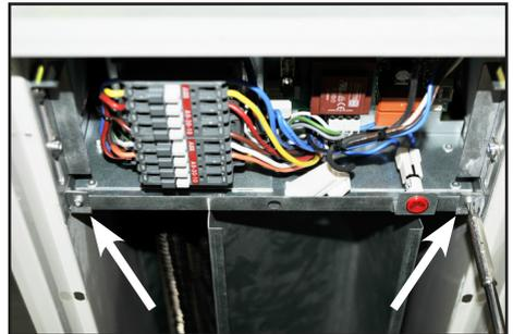
Verrouiller le bloc de ventilation sur les glissières à l'aide de 2 vis.
