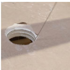
Percer le faux plafond au diamètre 75 mm
