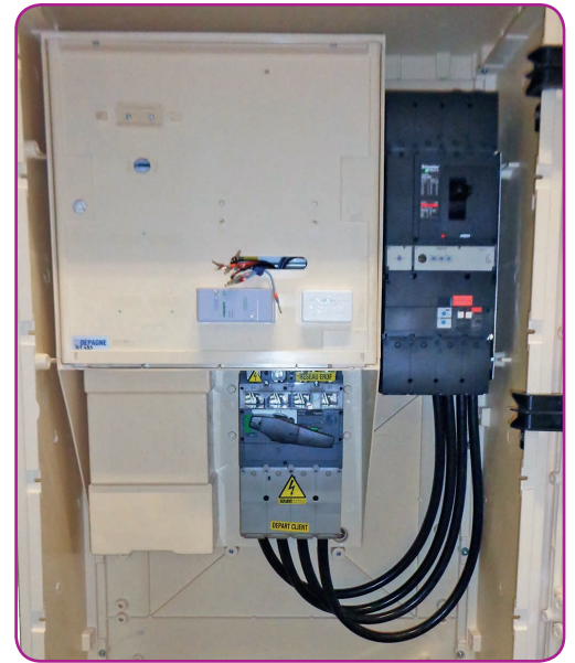
Exemple d'équipement intérieur : coffret BPS 400A avec sectionneur + disjoncteur (AGCP)
