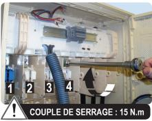
3 Isoler les câbles du faisceau (I & U) en les câblant sur le bornier.
