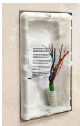
Remplacement de la platine de rue
