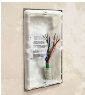
Remplacement de la platine de rue
