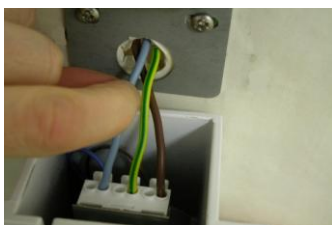
Raccorder l'applique au réseau :
