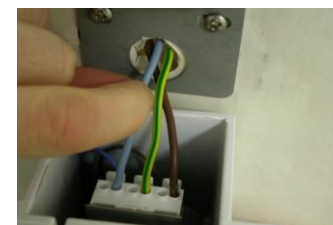
Raccorder l'applique au réseau :
