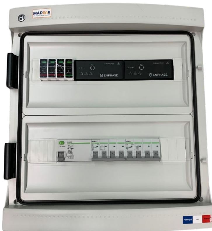
Figure 32 : Photo coffret AC 2 arrivées micro-onduleur TRI 9-18kW ref 23101820
