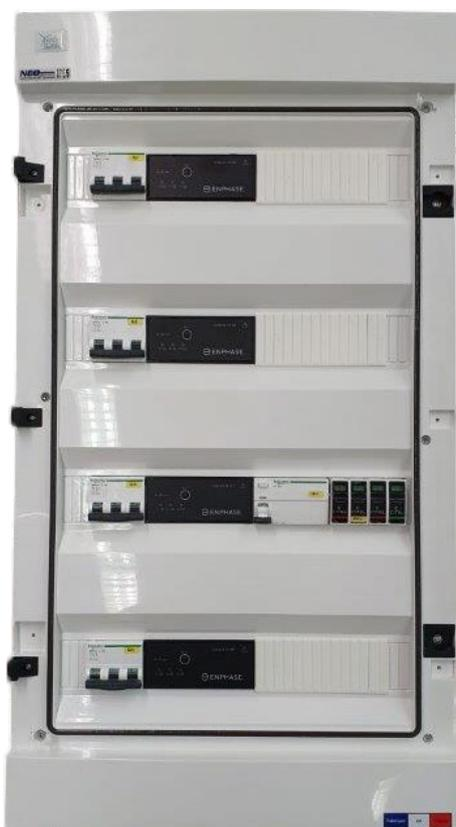
Figure 33 : Photo coffret AC 4 arrivées micro-onduleur TRI 25-36kW ref 23103640
