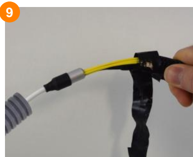
9 Pour un kit préconnectorisé, après avoir récupéré la chaussette de tirage à la sortie du conduit (ø25 mm mini), retirer l'adhésif et dégager les fiches optiques en tirant la gaine de la chaussette. Couper le tube noir puis retirer intégralement la chaussette pour récupérer la ou les fiches connectorisées en usine.
