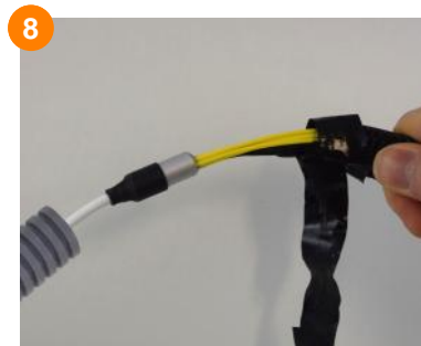
8 Pour un kit préconnectorisé, après avoir récupéré la chaussette de tirage à la sortie du conduit (ø25 mm mini), retirer l'adhésif et dégager la zone de séparation des fibres en tirant la gaine. Couper le tube noir puis retirer intégralement la chaussette pour récupérer la ou les fiches connectorisées en usine.
