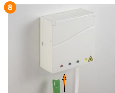
8 Pour faire les mesures de contrôle ou pour raccorder un appareil au réseau optique, brancher un cordon optique sur une sortie de la PTO.
