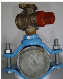
6) Vissage du robinet jusqu'au contact avec la rondelle de protection.
