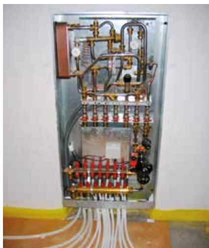
Montage encastré d'un module d'appartement avec unité de distribution pour plancher chauffant.
