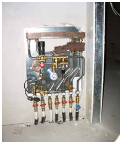
Montage mural d'un module d'appartement.
