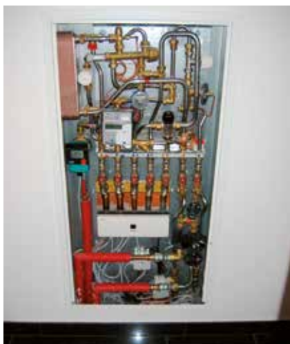
Montage encastré d'un module d'appartement avec unité de distribution et régulateur pour plancher chauffant.
