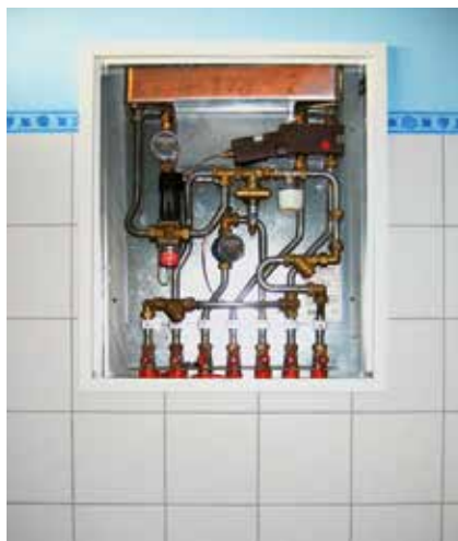
Module d'appartement encastré dans une salle de bains.
