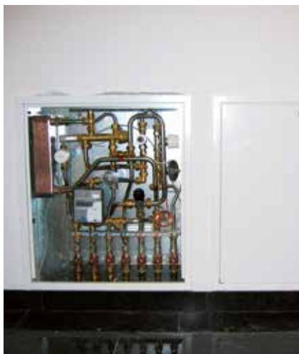
Montage encastré dans le sol d'une cuisine.
