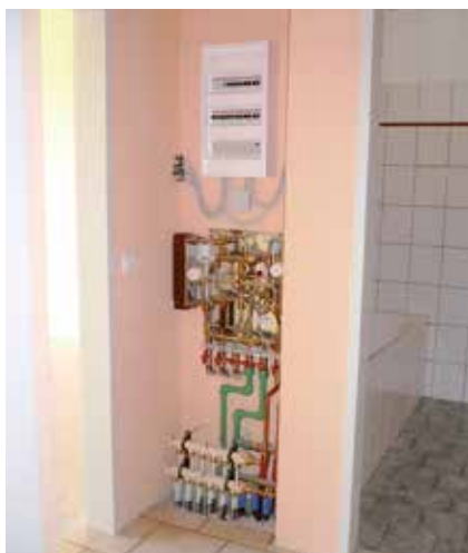
Module d'appartement monté dans une gaine ou un placard.
