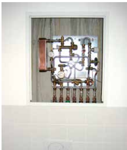
Module d'appartement encastré dans une gaine de salle de bains.
