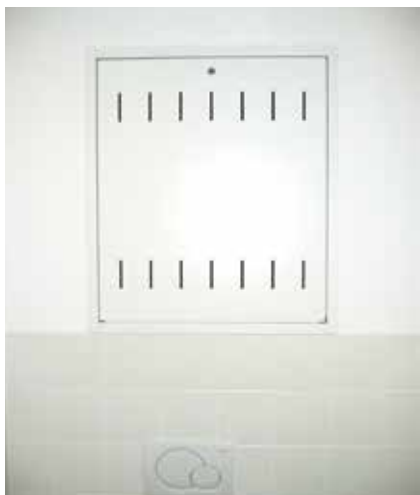
Module d'appartement avec capot, encastré dans une gaine de salle de bains.
