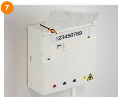
7 Poser les étiquettes d'identification sur le capot (une étiquette collée sous la trappe et l'autre collée à l'intérieur du capot).
