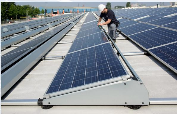
Les systèmes innovants ont été conçus de façon à maximaliser l'aisance et la durabilité. Robuste, résistants aux vents forts, flexibles et surtout simple à installer. Un seul outil est nécessaire pour tout le montage!
