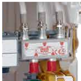
RÉPARTITEUR TV DU COFFRET FULL MEDIA COAX/RJ 45 POUR LOGEMENT T4, T5, T6 (RÉF. 0 930 77)
