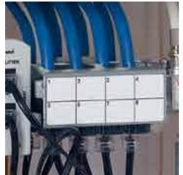
COFFRET FULL MEDIA COAX/RJ 45 POUR LOGEMENT T4, T5, T6 (RÉF. 0 930 77)
