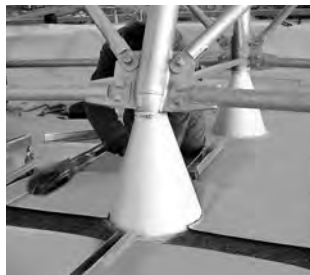
Fig. 6: Takområde med mange gjennomføringer
