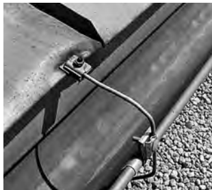
Fig. 10: Feilaktig tilkobling av lynvernklemmen til banene
