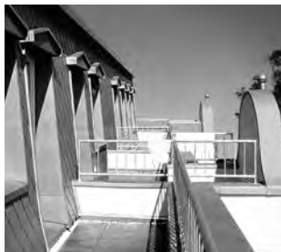
Fig. 26: Bruk av RHEINZINK-beslagsprofil ved murdetaljer
