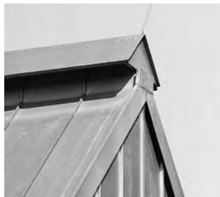
Fig. 11: Fluktende møneavslutning på vindski, høy utførelse
