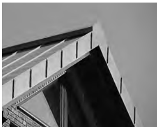
Fig. 12: Fluktende møneavslutning på vindskibeslag falset, lav utførelse
