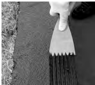
Fig. 4: Enkolit® påføres med rillet sparkel
