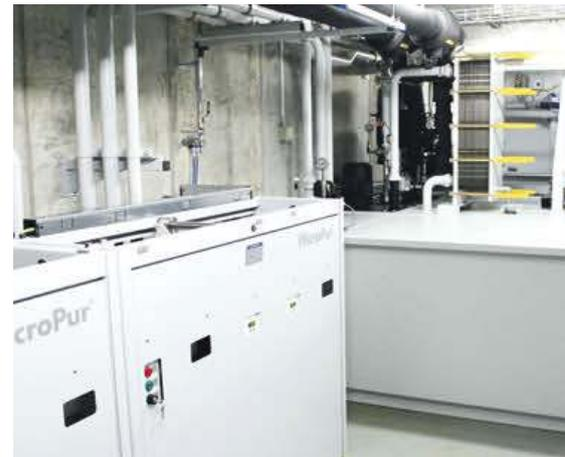
**Arbeit im Verborgenen:** Unter der Produktionshalle befindet sich die neue KSS-Zentralanlage. Sie besteht aus zwei Knoll-Kompaktfiltern KFE 600 und einem Feinstfilter Micropur 600 F.
