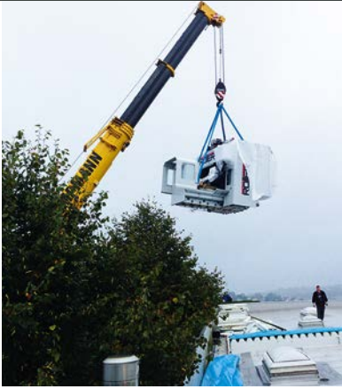
Hakenmaschine: wörtlich genommen. Drei Stunden Zeit hatten die Logistiker, um die fast 19 Tonnen schwere Maschine anzuliefern und mit einem Kran durch ein Loch im Dach in die Produktionshalle zu heben. Adrenalin pur bei allen Mitarbeitern. (Bilder: Canto)
