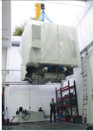
Hakenmaschine: wörtlich genommen. Drei Stunden Zeit hatten die Logistiker, um die fast 19 Tonnen schwere Maschine anzuliefern und mit einem Kran durch ein Loch im Dach in die Produktionshalle zu heben. Adrenalin pur bei allen Mitarbeitern. (Bilder: Canto)
