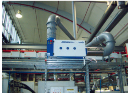
Ein Ölnebelabscheider im Lkw-Werk von MAN in München hält den langen Abluftkanal sauber
