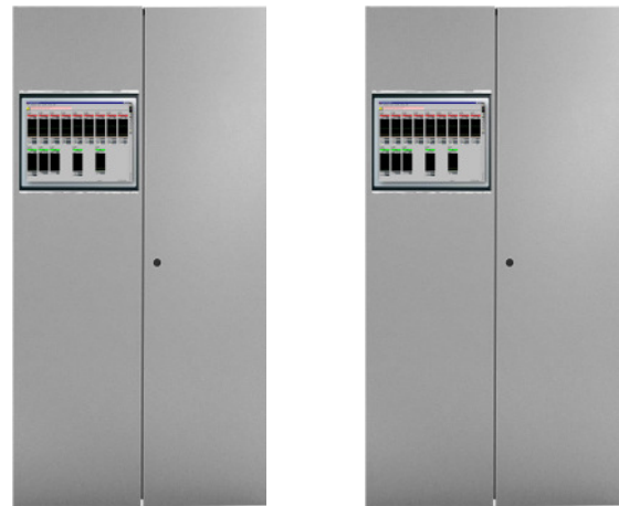
Schaltschränke mit FP1600 und Touch IPC
