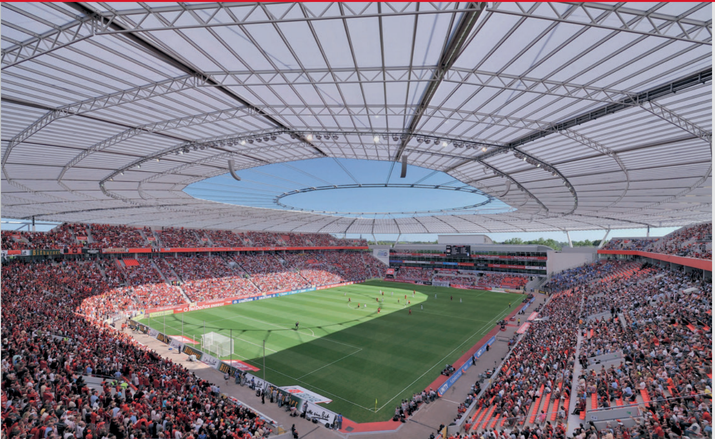
Überdachungsdesign der BayArena: Dachwerkstoff ist Polycarbonat wegen seiner Transparenz, Stabilität, Schlagzähigkeit und Witterungsbeständigkeit (Bilder: Bayer)
