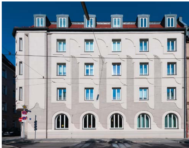
Bild 1. Das Münchner Abgeordnetenhaus in der Ismaninger Straße erhielt ein reliefartig gestaltetes Wärmedämmverbundsystem (WDVS). Damit konnten die Ziele der Energieeinsparverordnung sogar unterschritten werden (© Landeshauptstadt München /M.Kaltenbach)
