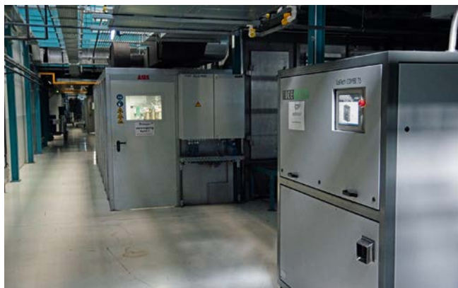
Bedarfsgerechte Trockeneisproduktion: Die Versorgungs- und Pelletizer-einheit des Trockeneisstrahlsystems ist im Bereich der Lackversorgung platziert und ermöglicht damit einen kontinuierlichen Strahlprozess
