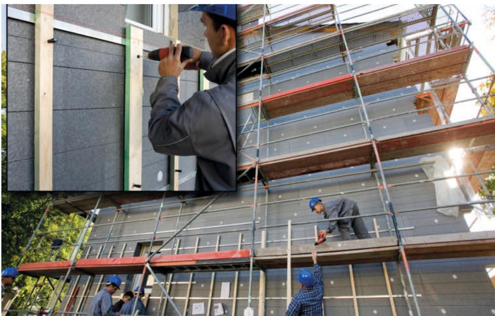
**Bild 3. Fassadensystem Lambda Vento: Die EPS-Platten bieten eine sehr gute Wärmedämmung** (Foto: BASF)
