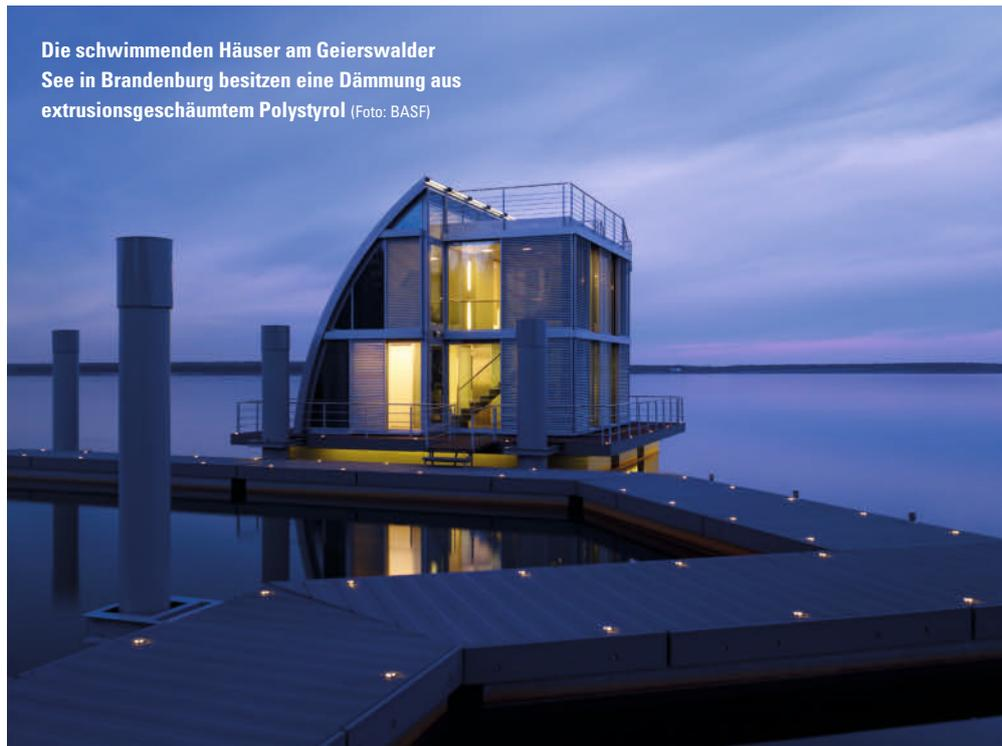
Die schwimmenden Häuser am Geierswalder See in Brandenburg besitzen eine Dämmung aus extrusionsgeschäumtem Polystyrol (Foto: BASF)
