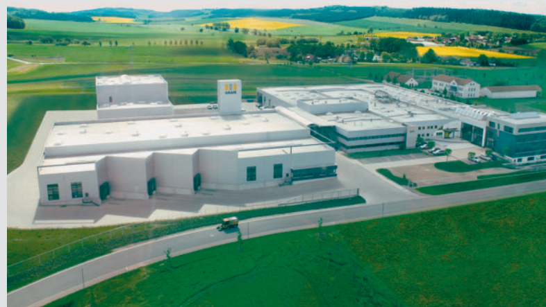
Der 1995 neu erbaute Firmenkomplex der Grafe Advanced Polymers GmbH in Blankenhain (Fotos: Grafe)
