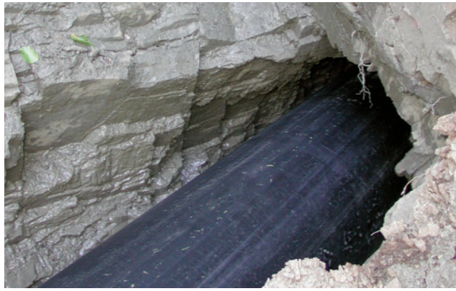
Bild 8. Neue, besonders spannungsrisstbeständige PE-HD-Typen für die Rohrherstellung werden durch hohe Punktlasten nicht mehr so stark in Mitleidenschaft gezogen wie konventionelle Polyethylen-Varianten. Damit lassen sich die Produkte besonders wirtschaftlich verlegen
