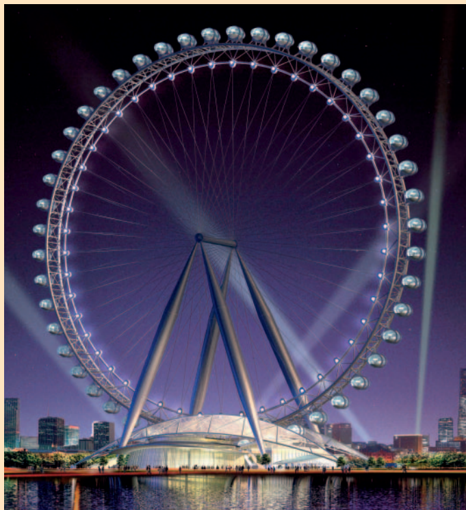
Das größte Riesenrad der Welt entsteht in China. Angetrieben wird das Rad mit 208 Metern Höhe von einem nahezu wartungsfreien Hydraulikaggregat und Hydraulikmotoren (Bilder: Bosch Rexroth)
