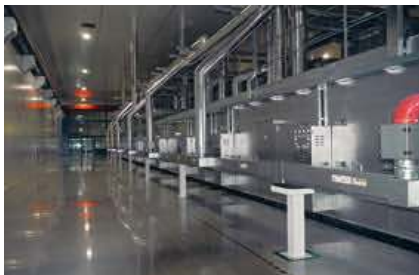
Bild 4. Die Querreck-PET-Verpackungsfolienanlage ist durch eine Glasabtrennung vom Reinraumbereich getrennt (Bild: Lindauer Dornier)
