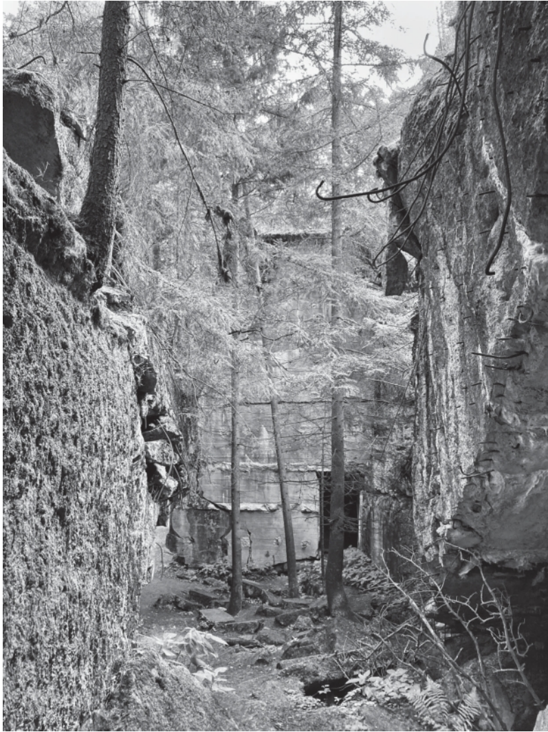
Abb. 4: Eingang zu einer Bunkeranlage
