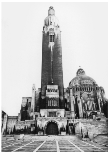
16 Lüttich, Mémorial interallié für die Verteidiger von 1914, errichtet 1937
