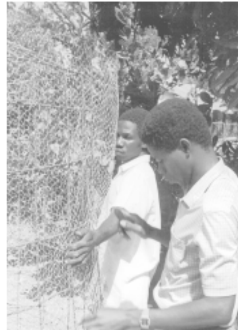
Les barres de renforcement se tordent pour donner la forme du toit.
