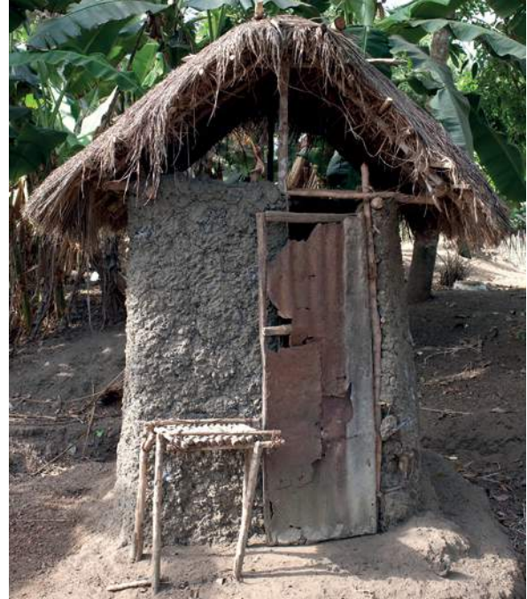
Des toilettes de petite taille avec une porte étroite peuvent être inaccessibles pour les personnes à mobilité réduite. Photo : Ralph Hodgson/Tearfund
