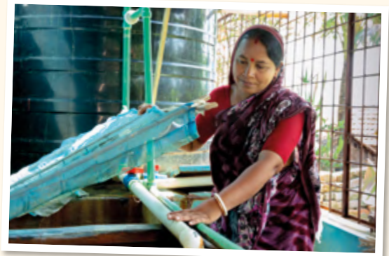
📍 Gita Roy verifica los equipos en la planta de tratamiento de agua que ayuda a operar.
