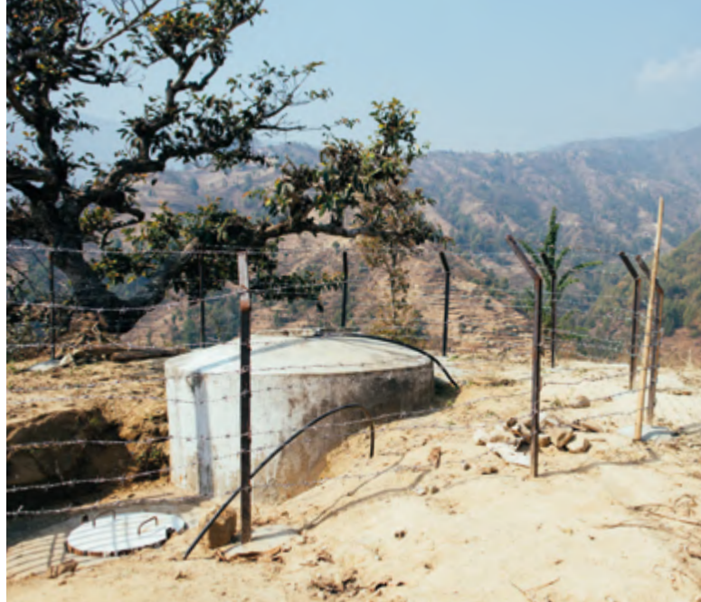
Este tanque de agua alimentado por gravedad en Nepal está protegido por una valla para mantener a los animales alejados del suministro de agua de la aldea. Un comité de agua y saneamiento es responsable de probar la calidad del agua con regularidad y mantener el equipo. Foto: Tom Price/Tearfund
