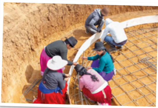
▣ Miembros de la comunidad en Ecuador preparan el terreno para su nuevo tanque de agua. Foto: Codeinse
