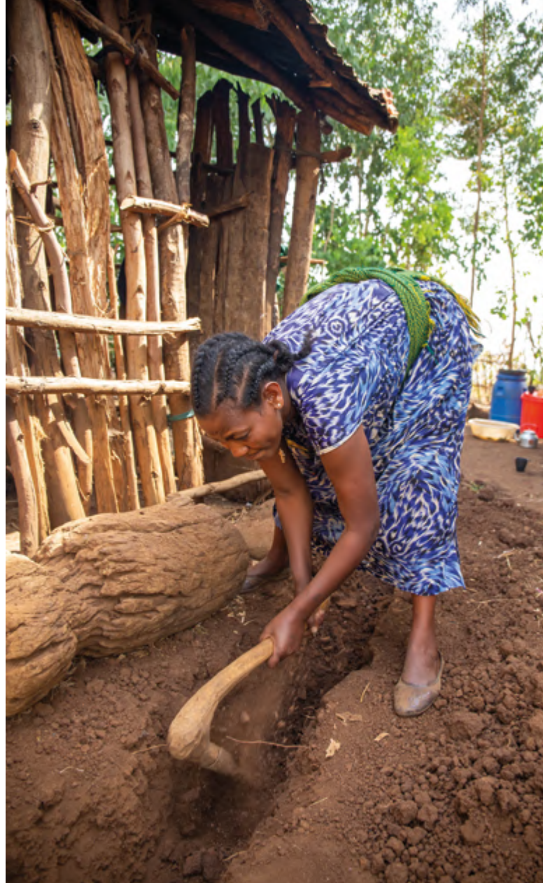
❏ Tiru Getahun, recaudadora de pagos del comité de agua de su aldea en Etiopía, cava una zanja para hacer una extensión de tubería de agua a su casa. Foto: Frehiwot Gebrewold/WaterAid
