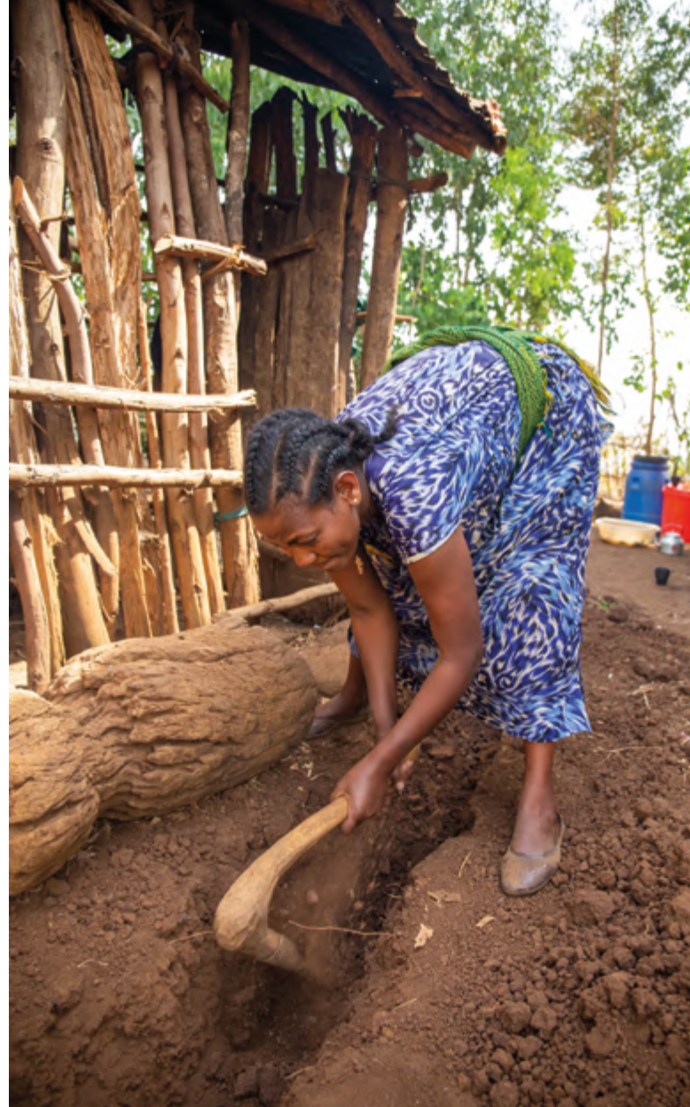
📍 Tiru Getahun, que cobra as taxas para o comitê de água do seu povoado na Etiópia, cavando uma vala para estender uma tubulação de água até sua casa. Foto: Frehiwot Gebrewold/WaterAid
