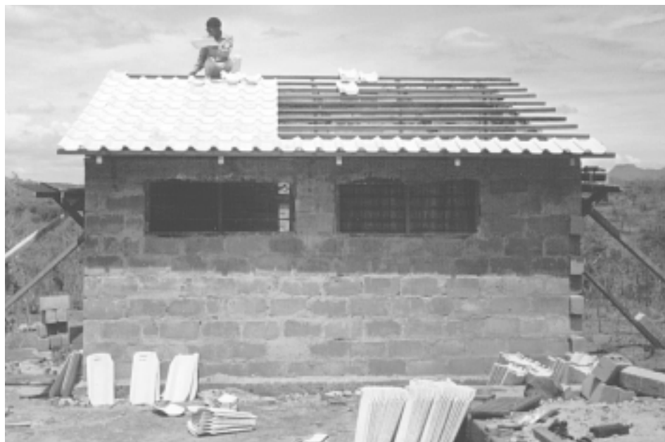
Um telhado precisa de uma estrutura forte. As telhas são mais pesadas do que chapas de metal. O telhado precisará ser bem construído com medidas e vigas transversais precisas.
