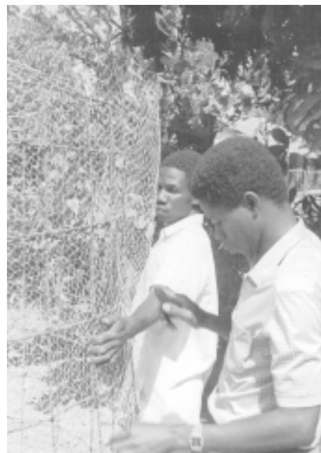
Hastes de reforço são dobradas para fazer o formato do telhado.
